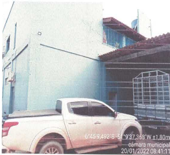
Figura 6: Fachada Posterior da Edificação.
