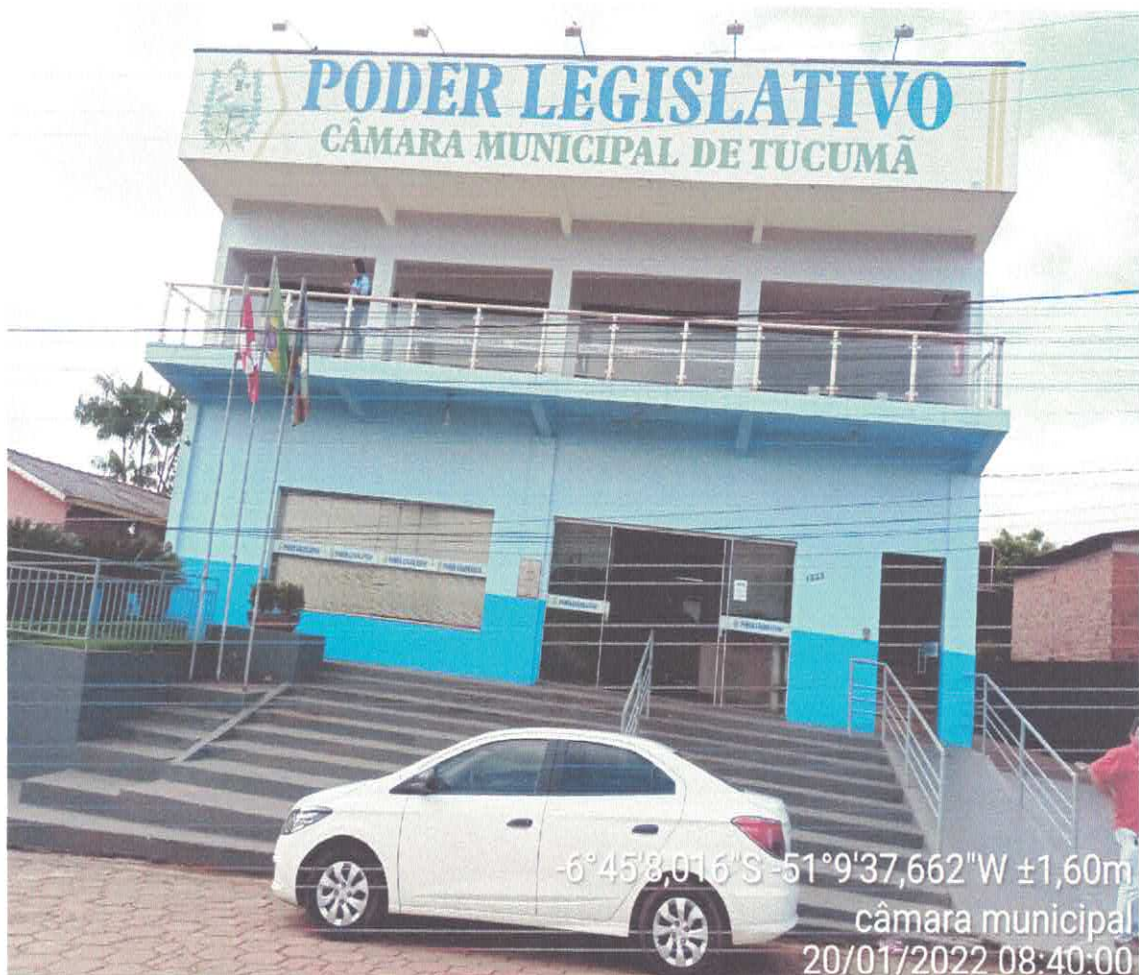
Figura 1: Fachada Principal da Edificação
