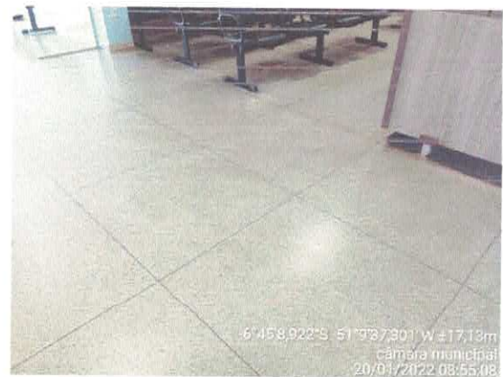
Figura 9: Piso em granitina no Pavimento Térreo.
