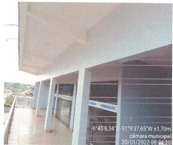
Figura 8: Pavimento Superior, entrada para as salas.
