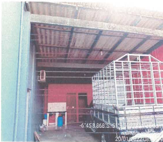
Figura 10: Cobertura externa para Estacionamento.
