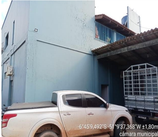
Figura 6: Fachada Posterior da Edificação.
