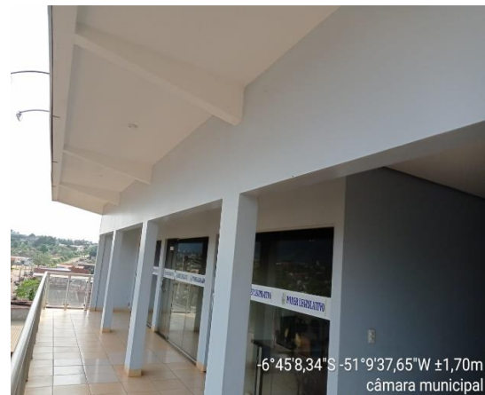
Figura 8: Pavimento Superior, entrada para as salas.
