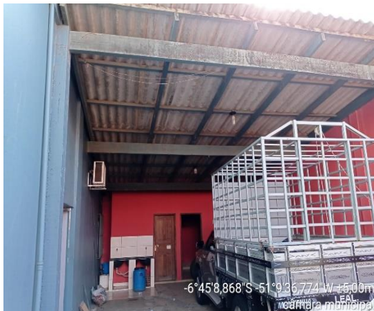
Figura 10: Cobertura externa para Estacionamento.
