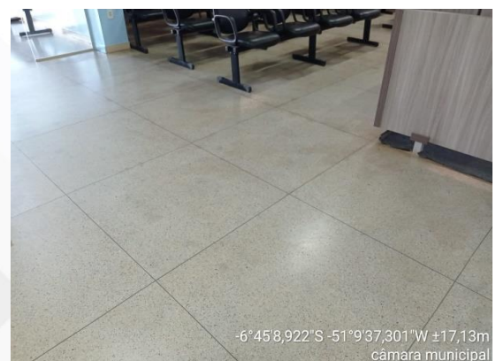
Figura 9: Piso em granitina no Pavimento Térreo.
