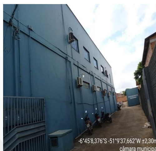
Figura 5: Lateral da Edificação.
