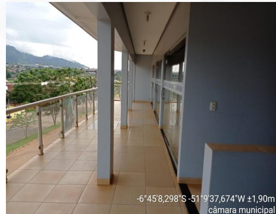
Figura 9: Varanda, pavimento Superior da edificação.
