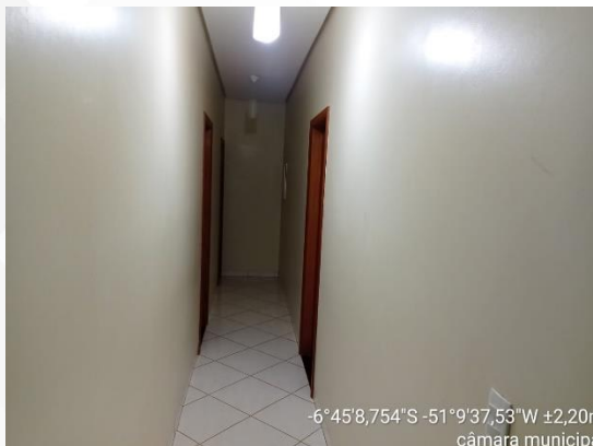
Figura 7: Corredor de acesso as salas do pavimento Superior.
