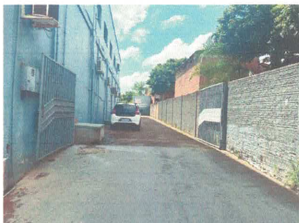
Figura 7: Lateral da Edificação
