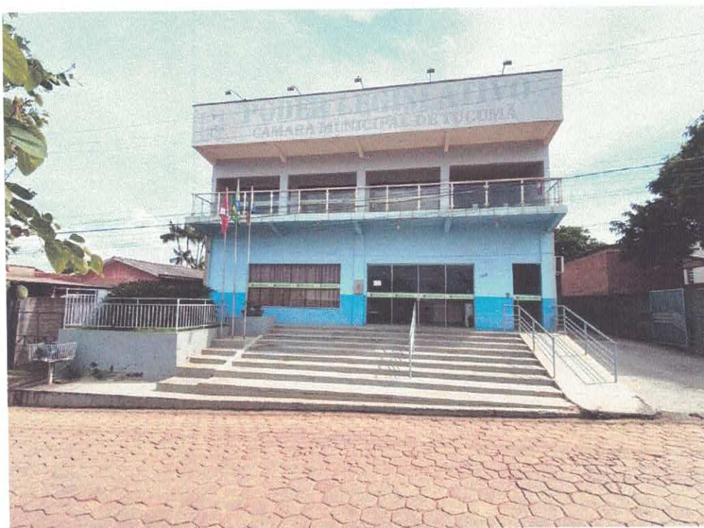
Figura 1: Fachada Principal da Edificação
