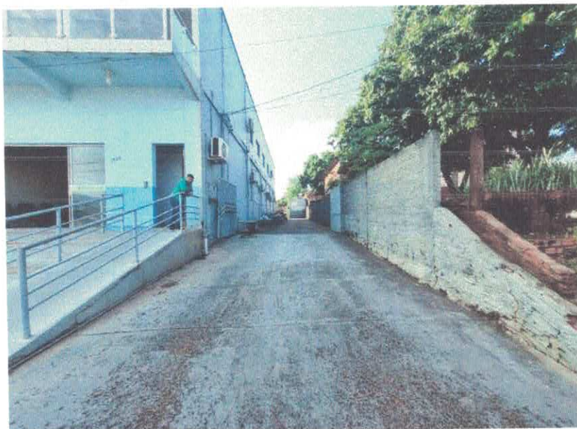
Figura 8: rampa de acesso estacionamento.
