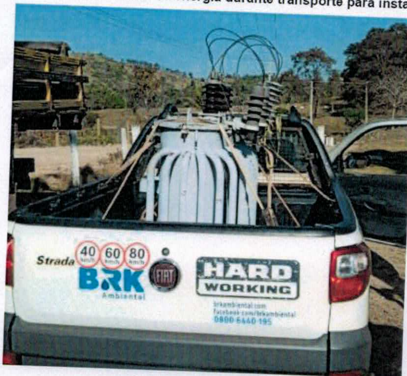
Figura 11 – Transformador de energia durante transporte para instalação.
